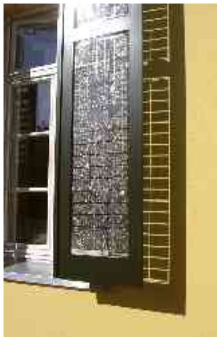
Ansicht: Solarer Fensterladen an denkmalgeschütztem Haus
